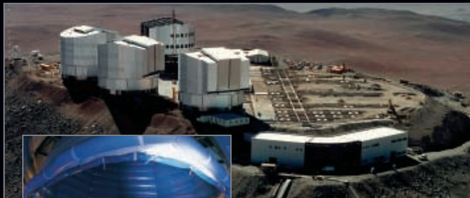
Standort des VLT ist der 2660 Meter hohe Cerro Paranal in der chilenischen Atacama-Wüste.
