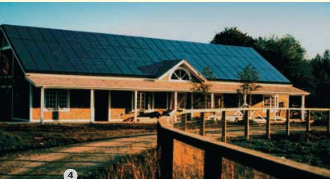
Ein kleines Kraftwerk besitzt die Weyerhouse Residence (Federal Way/Washington): ein dachintegriertes photovoltaisches System ersetzt die Ziegel und liefert zugleich Strom.
