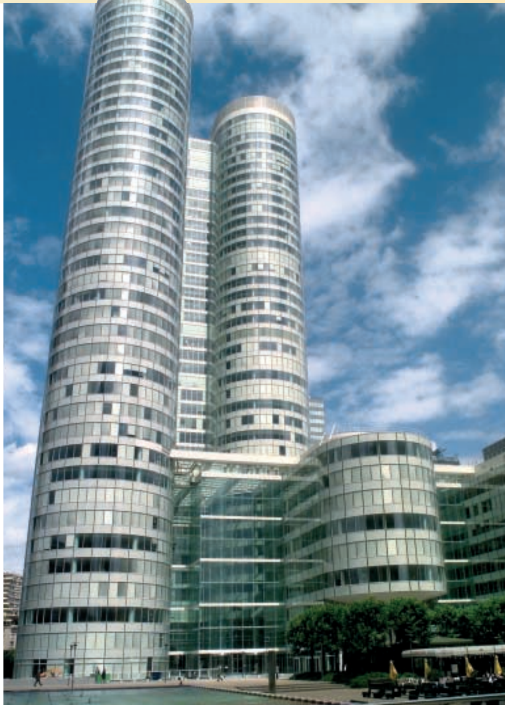
Im Verbindungsteil zwischen den Zwillingstürmen sorgen 10.000 Quadratmeter „Pyran S“ im Brandfall für ein Plus an Sicherheit.
