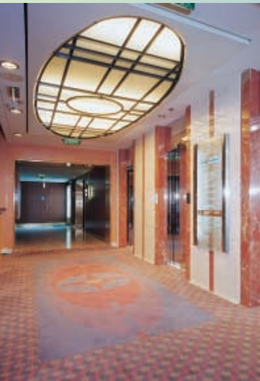
Wartungsfreundlich: faseroptische Deckenbeleuchtung im Aufzugsbereich.
