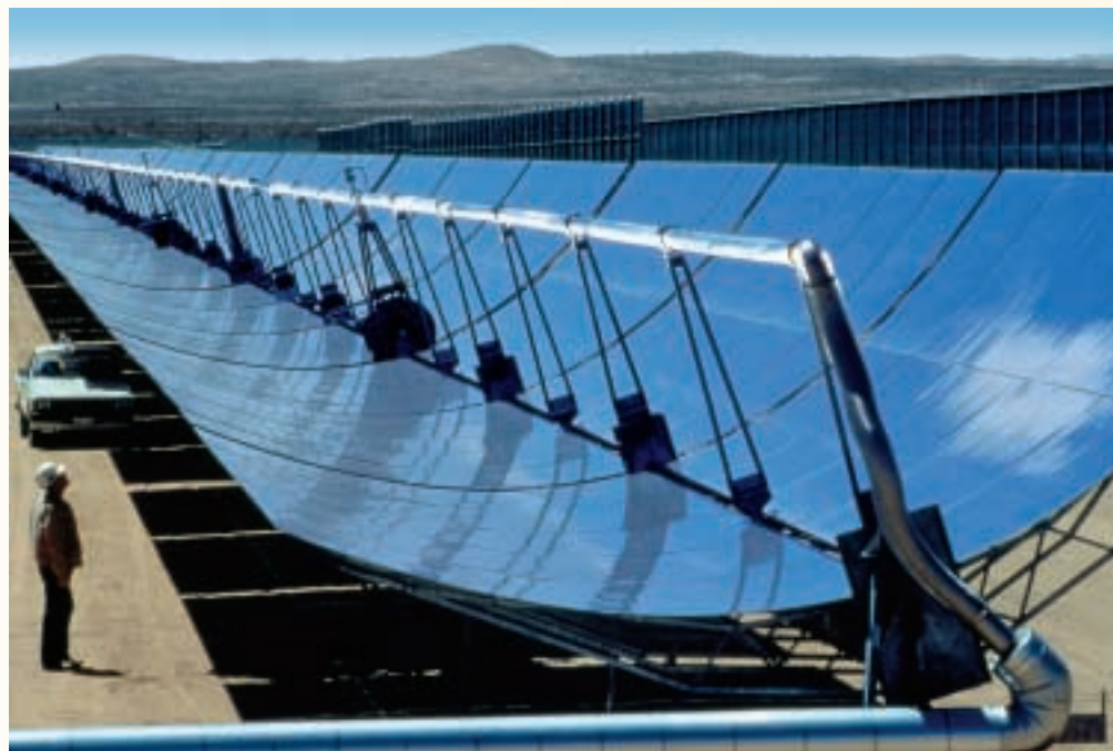
Für die Röhrenkollektor- (oben) und Parabolrinnentechnik (unten) will Schott-Rohrglas u.a. verbesserte Antireflex-Schichten entwickeln, die zu höherer Energieausbeute führen.
