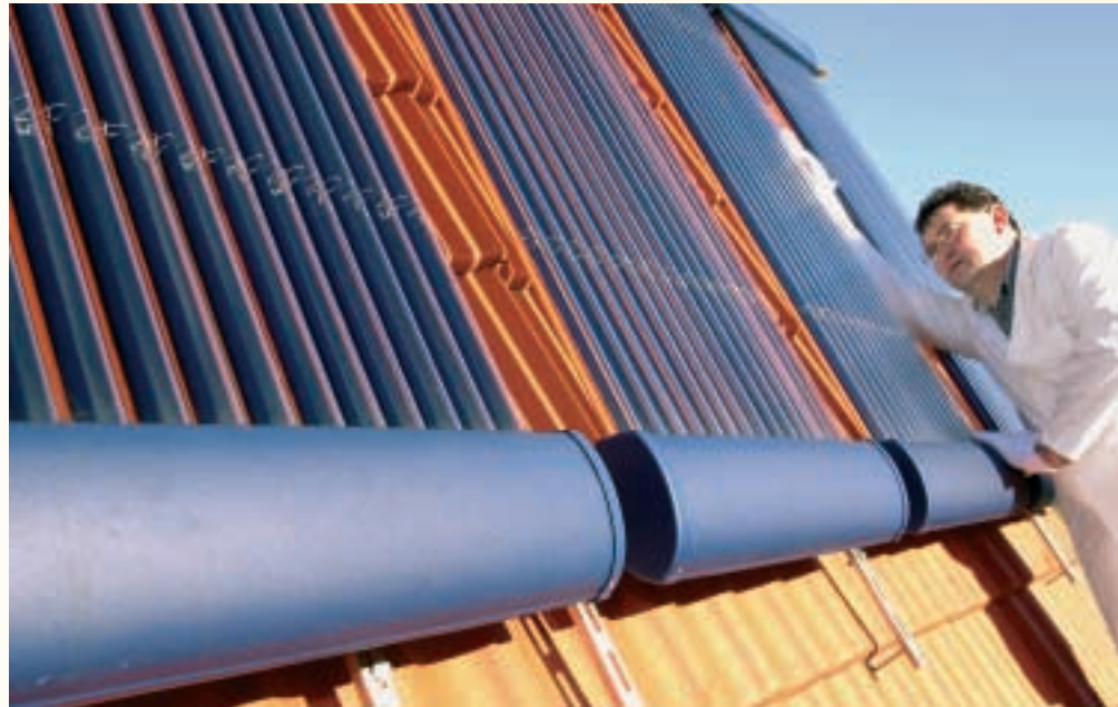
Für die Röhrenkollektor- (oben) und Parabolrinnentechnik (unten) will Schott-Rohrglas u.a. verbesserte Antireflex-Schichten entwickeln, die zu höherer Energieausbeute führen.
