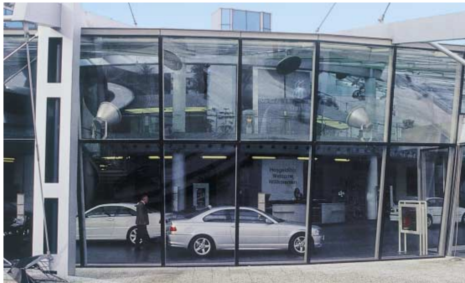
Verre traditionnel en partie haute, AMIRAN® en partie basse de la façade.
