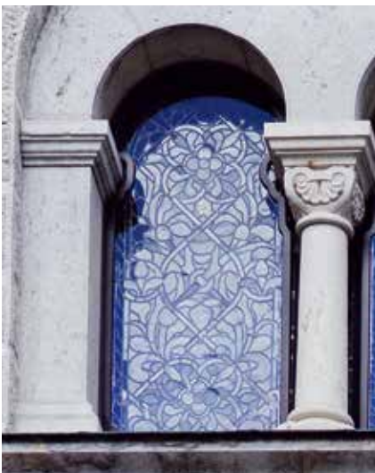
SCHOTT AMIRAN® Heritage Protect vor Bleiverglasung
