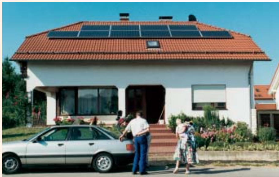
Photovoltaik-Anlagen auf dem Dach eines Einfamilienhauses. Der meiste Solarstrom wird erzeugt, wenn die Module nach Süden ausgerichtet und in einem Neigungswinkel von 30° angebracht sind.
