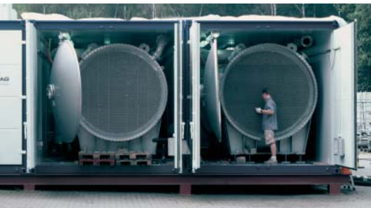
Die Ozongeneratoren werden in Großraum-Container installiert.
