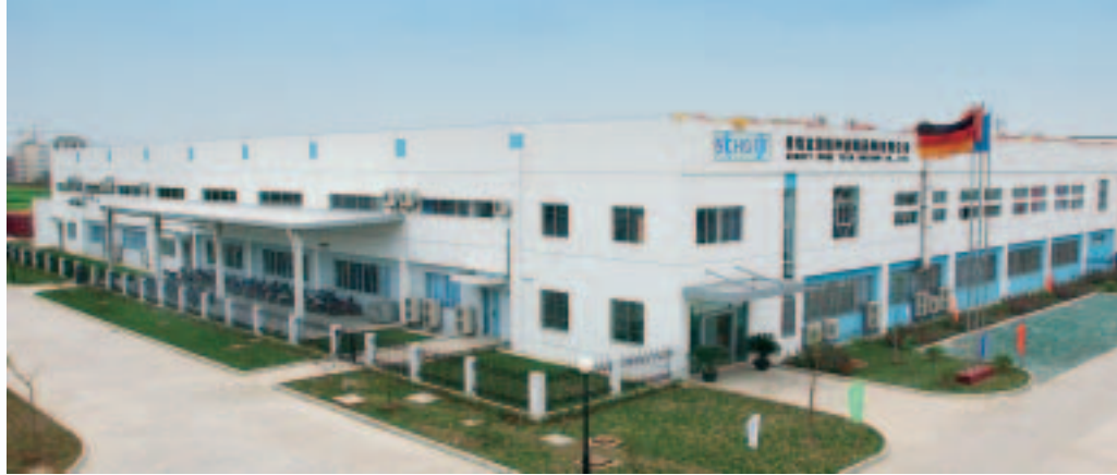
Die neue Produktionsstätte von Schott China: Schott Home Tech Co. Ltd. in Suzhou
