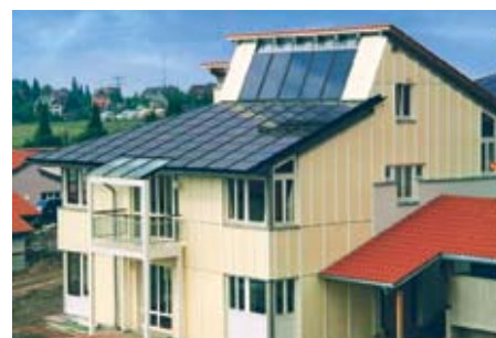
Paneles integrados en tejado
